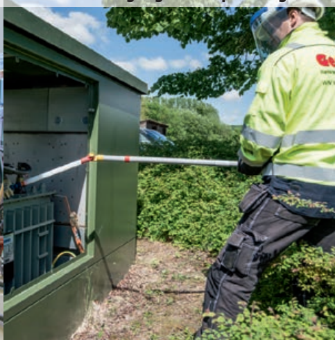
Traforeinigung unter Spannung
